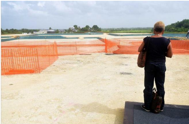
Les terrassements sont désormais achevés. Les travaux commenceront en janvier. (Photo : Dominique CHOMEREAU-LAMOTTE)
